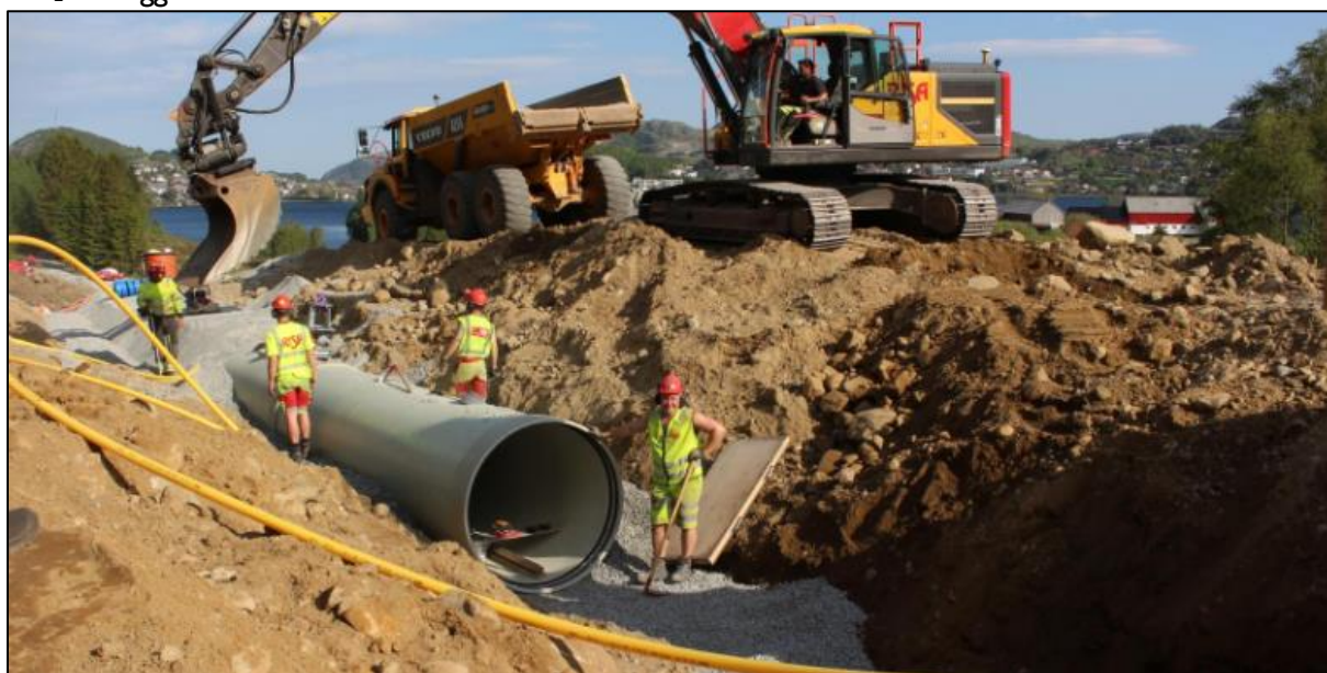
Legging av første del av Hovedvannledning vest. Bilde er hentet fra IVAR sin hjemmeside.
